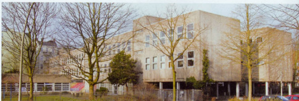
In der Staatlichen Gewerbeschule Stahl- und Maschinenbau in Hamburg sind alle Sanitärräume mit wassersparender Sanitärtechnik ausgerüstet.
