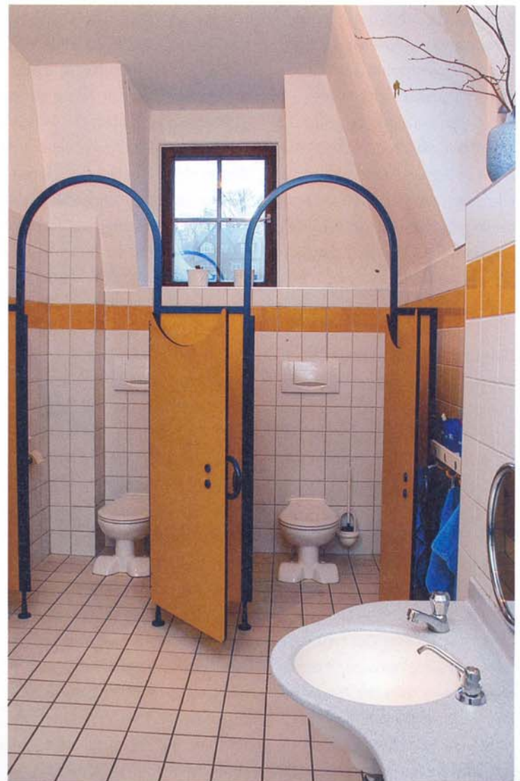
Bild 7 • Auch in diesen beiden WC-Kabinen im Dachgeschoss wurden die Stand-WCs „Kind“ von Keramag eingesetzt. Durch ihre geringe Sitzhöhe von nur 340 mm und die seitlichen Fußstützen sind sie für Kinder von drei bis neun Jahren geeignet. Fotos: Keramag
