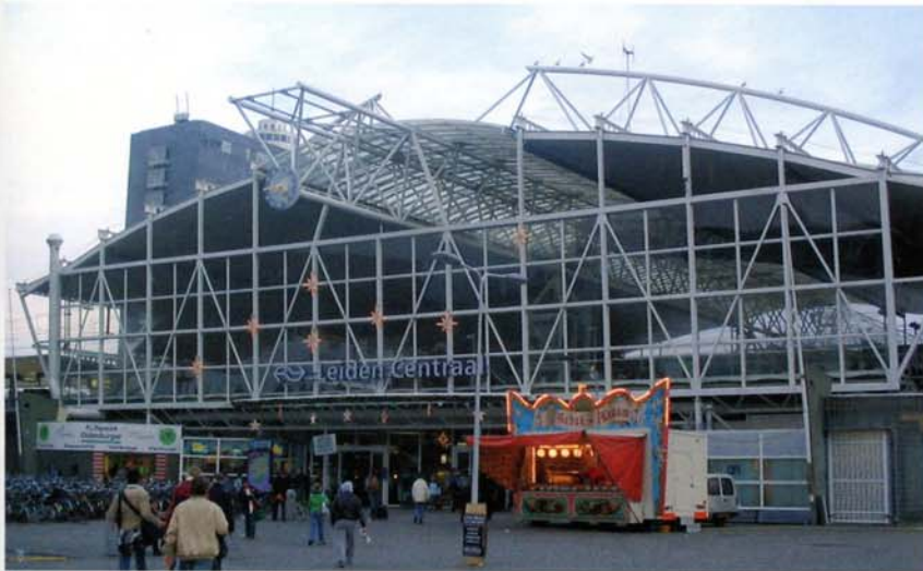
Bild 1 • „WelCome“: Bei der Sanierung des stark frequentierten niederländischen Bahnhofs Leiden Centraal wurde erstmals das modulare Premium-Sanitärkonzept umgesetzt.
