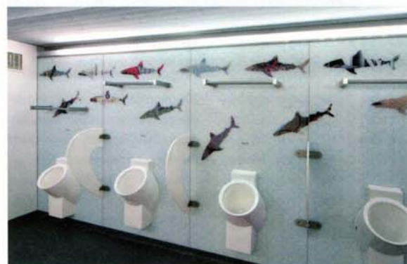
Bild 9 • Hygienisch und kostensparend: Die fünf im Bahnhof Leiden installierten wasserlosen Urinale Centaurus haben nicht nur eine schmutzabweisende Spezialglasur, sondern sparen der niederländischen Bahngesellschaft in einer Betriebszeit von etwa 13 Jahren auch über 25.000 Euro an Frisch- und Abwasserkosten ein.
